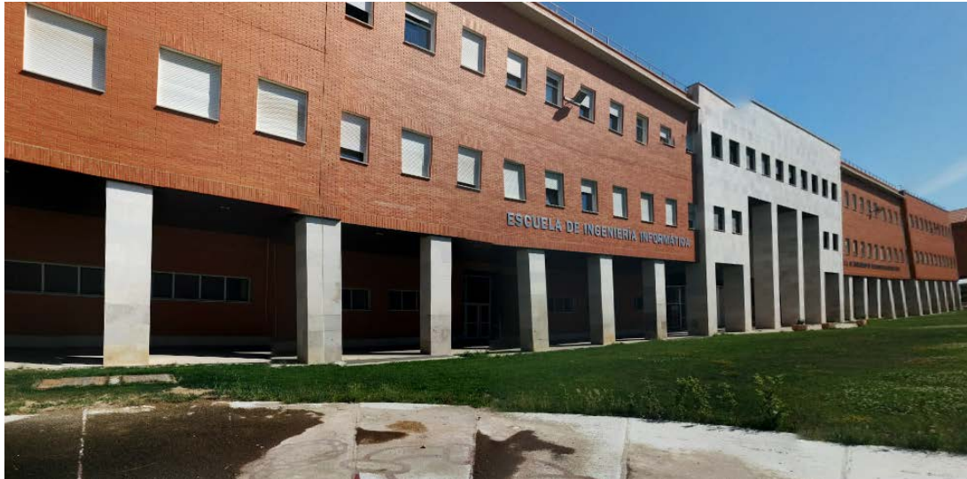
Vista del Edificio
